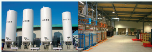
▲川口総合ガスセンター株式会社の新充填工場
