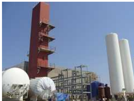
画像：ベトナム（ハノイ）にて建設が進む空気分離装置
