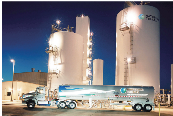
MTGの産業ガス生産工場(米国テキサス州アービング)
