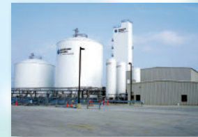
マチソン・トライガス社大型空気分離装置 (カリフォルニア州バーノン市) (2007年)
