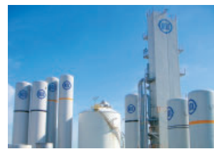
▲NOX 3号プラント全景
