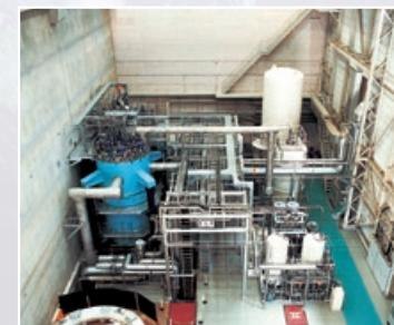
「大型ヘリウム冷凍液化装置」
