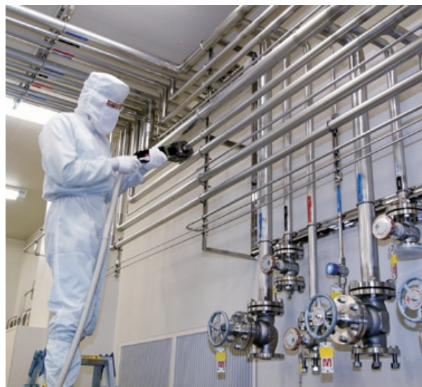
高純度ガス供給配管工事
