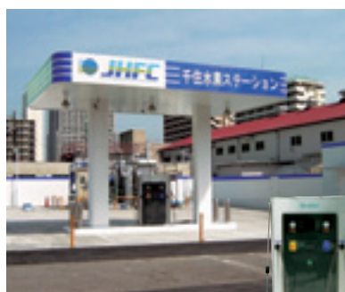
JHFC千住水素ステーション
