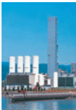
ガス生産工場
