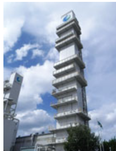
千葉サンソセンター五井工場第1号製造プラント
