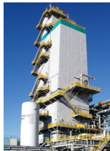
超大型空気分離装置
