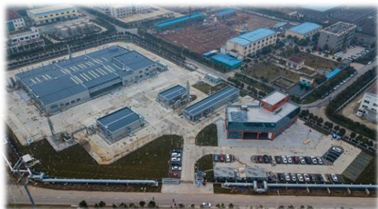
中国の電子材料ガス生産工場
