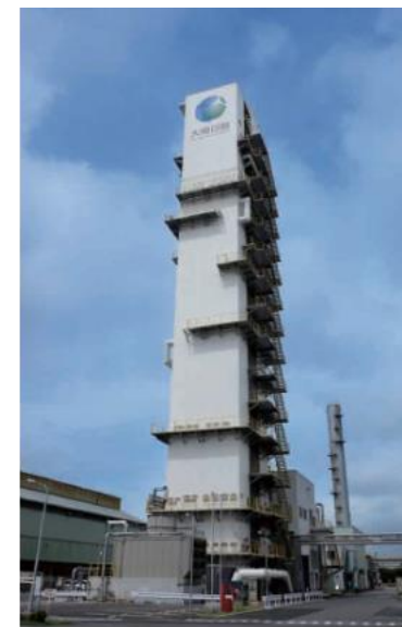
3号 製造プラント (山口県周南市)
