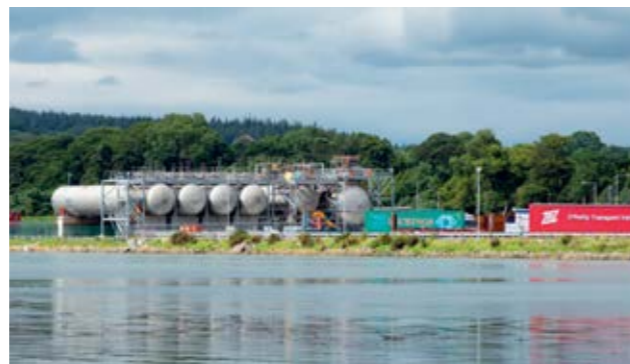
アイルランド北部に新しいCO 2 ターミナルを建設し、トレーラーの輸送よりも効率的な供給が可能に。これにより、輸送におけるCO 2 排出量を年間500トン削減できます。
