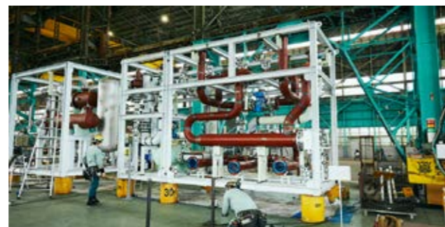
大陽日酸 プラントエンジニアリングセンター 京浜事業所での作業風景
