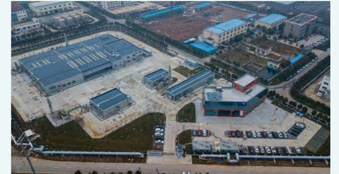
中国・揚州の電子材料ガス生産工場
