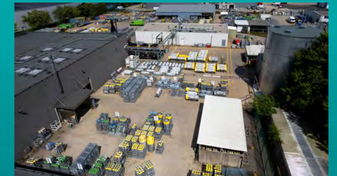
ベルギーの電子材料ガス工場
