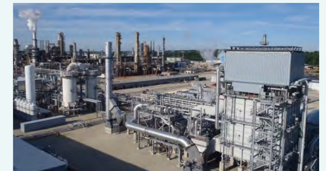
既存HyCOプラント
