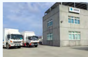
NSTWが保有する倉庫
