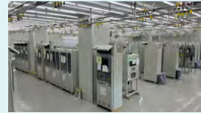
TNET機器製作工場
