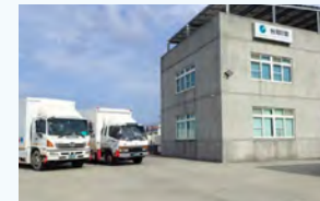
NSTWが保有する倉庫
